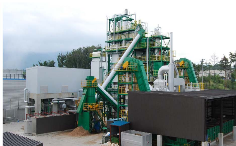
（写真－2） グリーン発電会津発電施設
